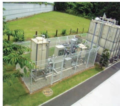
写真1 地下水膜ろ過システム
