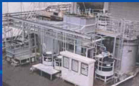
廃液処理施設
