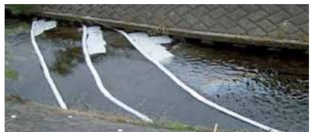
小型軽量オイルフェンスと多孔質吸着材系オイルマットの併用で対処した例
