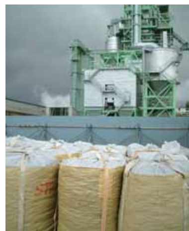
大手製紙メーカーのボイラー
