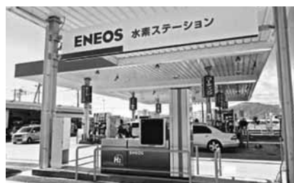
(固定式水素ステーション)
