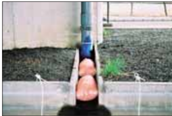
【浮き堰と「油ろ過袋」の設置例】
