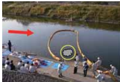
オイルフェンスを斜め展張し漏油の回収作業を行う。斜め展張することにより、手前・右岸側に流出油は自然に集まる、集まった油をフェンスで囲み込みオイルマットを投入する、回収する。河川一面にオイルマットを投入する場面を見かけると、資材を無駄にしているように思えます。
