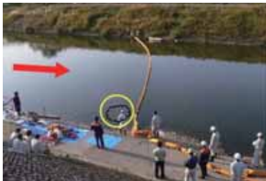
オイルフェンスを斜め展張し漏油の回収作業を行う。斜め展張することにより、手前・右岸側に流出油は自然に集まる、集まった油をフェンスで囲み込みオイルマットを投入する、回収する。河川一面にオイルマットを投入する場面を見かけると、資材を無駄にしているように思えます。
