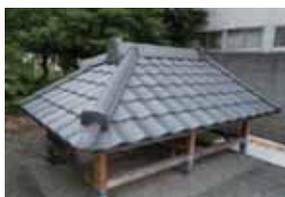
屋根材の原料はセメント、繊維材、混和材等ですが、グリーン調達比率を向上させるため、現在はフライアッシュ類（火力発電所などで石炭を燃焼させて発生した灰を電気集塵装置で回収したもの）やスクラップ（新築現場で発生した端材や製造工程で製品とならなかったものなどを再生材料にしたもの）などの再生材料を積極的に活用しています。新築現場などで発生する外壁材や屋根材の端材（切断した後の切れ端）のほとんどは産業廃棄物として処分されていましたが、それを回収し再原料化するリサイクルシステムを確立しています。当工場の主な製品は下写真になりますが、第一段階の製板工程は、原
