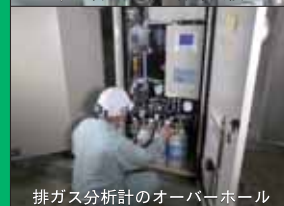
排ガス分析計のオーバーホール
