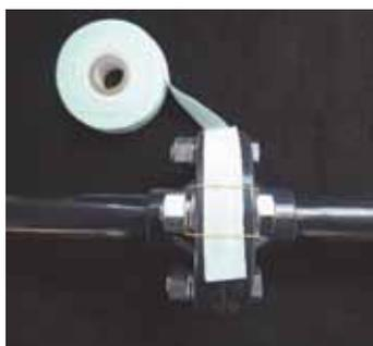
端部を輪ゴムで仮止めして巻き付け
