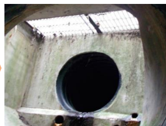
側溝下の雨水管に繋がる管
