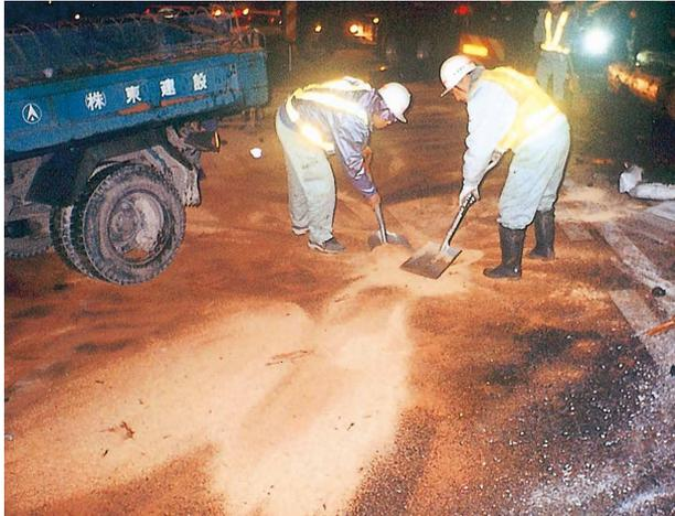
**交通事故等で路面に流出した有害液体の拡散防止と回収に**
